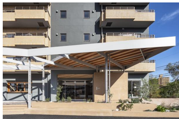
施工事例（『リノア北赤羽』）
