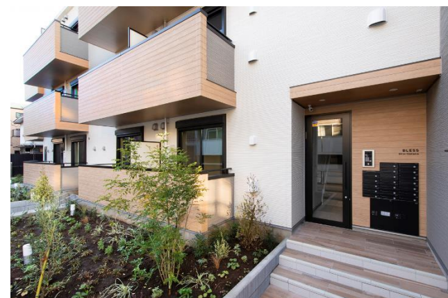
設計・施工事例 (BLESS新中野)
