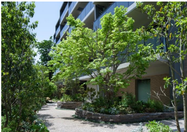
外観・外構写真
