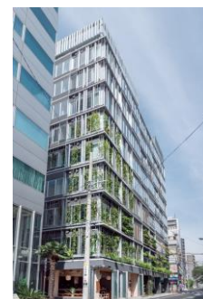
T-PLUS日本橋小伝馬町 (2022年4月竣工)
