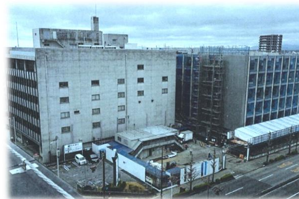
工事現況：2026年3月31日現在
