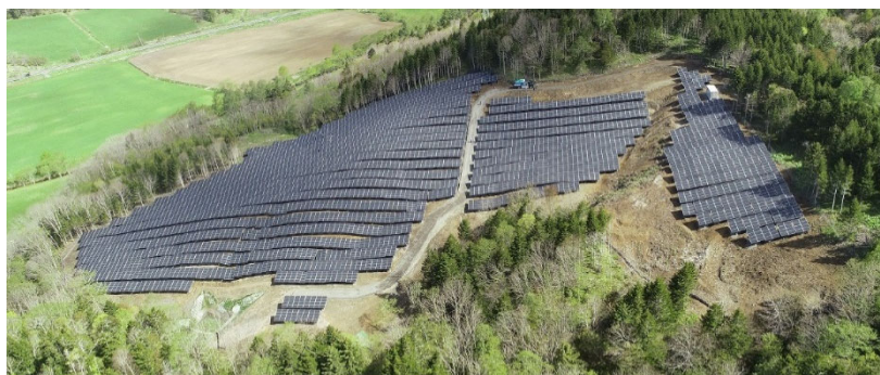
厚岸ルークシュポール太陽光発電所
