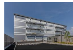
八尾物流施設 (2025年8月竣工)
