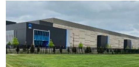
米国シカゴのデータセンター
