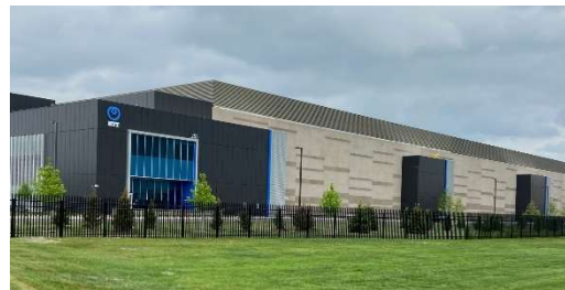
米国シカゴのデータセンター
