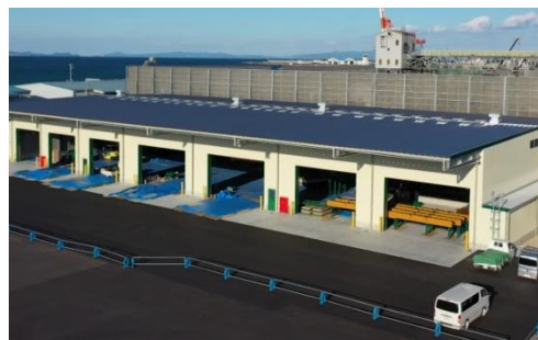
徳島製材工場の新工場着工
