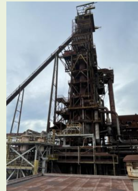
HBIを製造するシャフト炉
