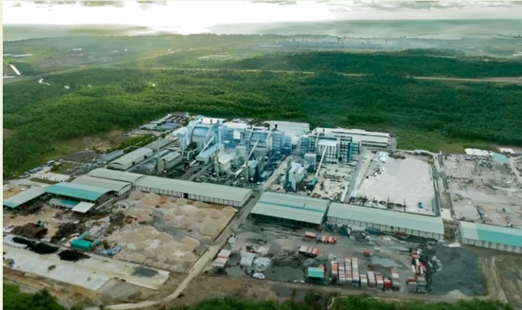
PMB SILICON SDN. BHD. 工場外観
