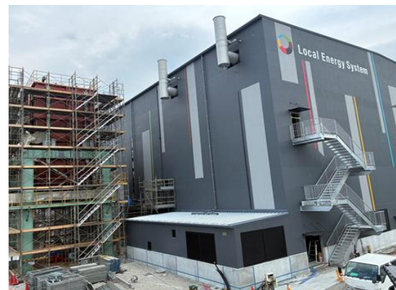
西条工場外観(建設中)
