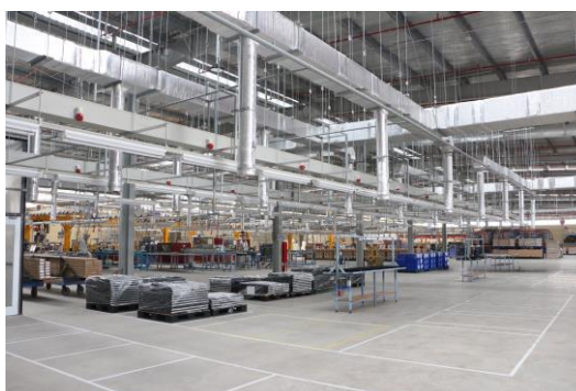
(新工場の内部)
