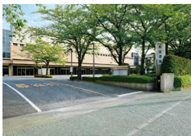
町屋齋場 (荒川区)
