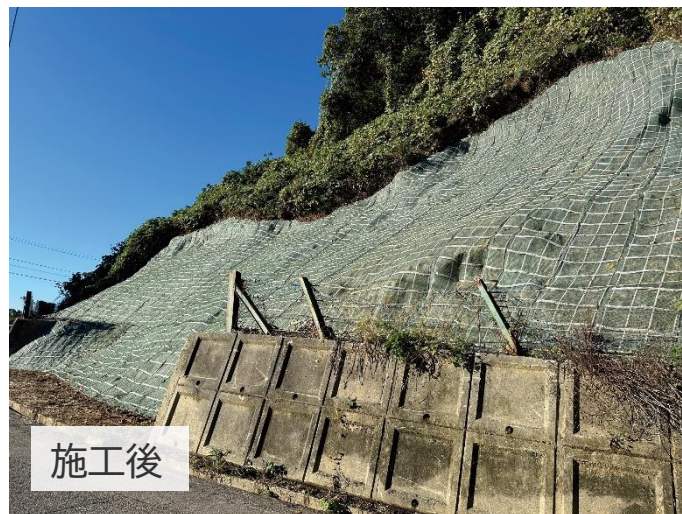
石川県津幡町 林道法面復旧工事
