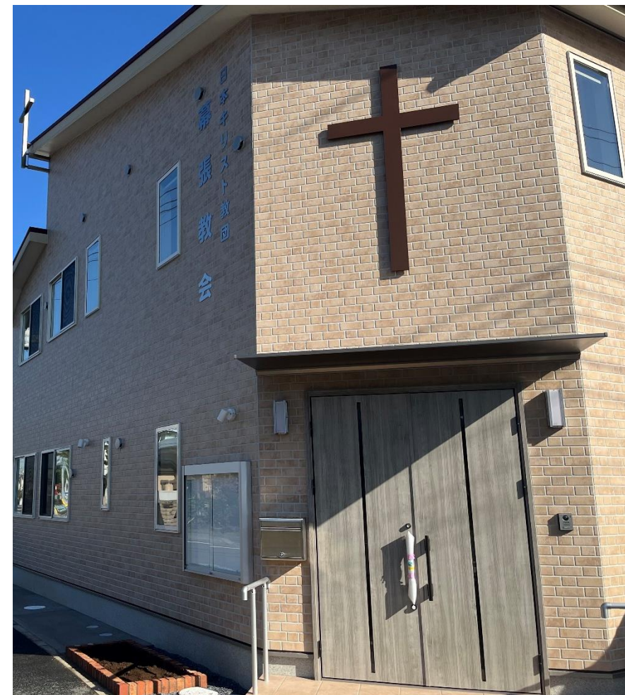
住宅兼施設（花見川区幕張町）
