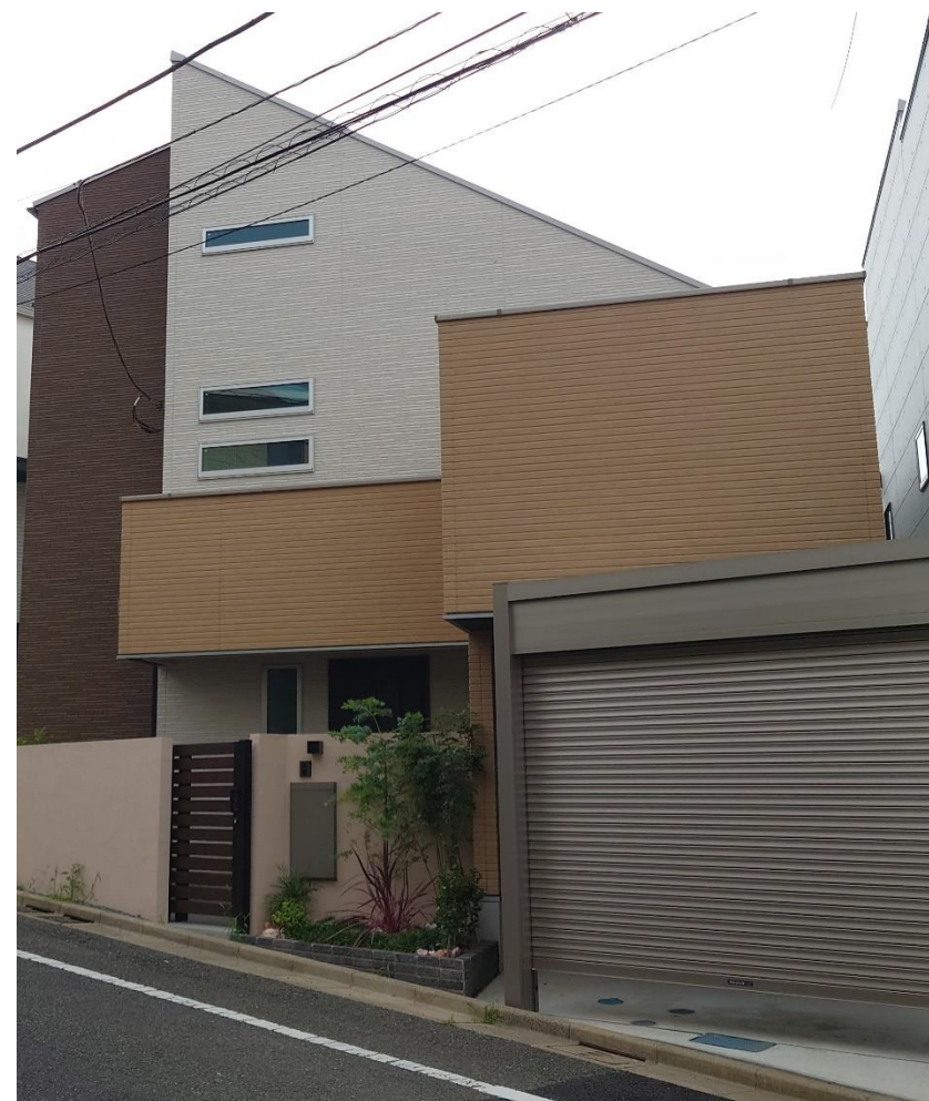
木造3階建住宅（世田谷区下馬）
