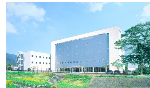
再生医療等製品の商用生産が可能な製造施設（右）
