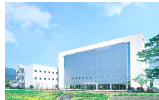
再生医療等製品の商用生産が可能な製造施設（右）
