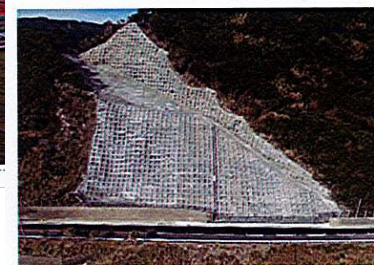
道路法面強化等の緊急対策
