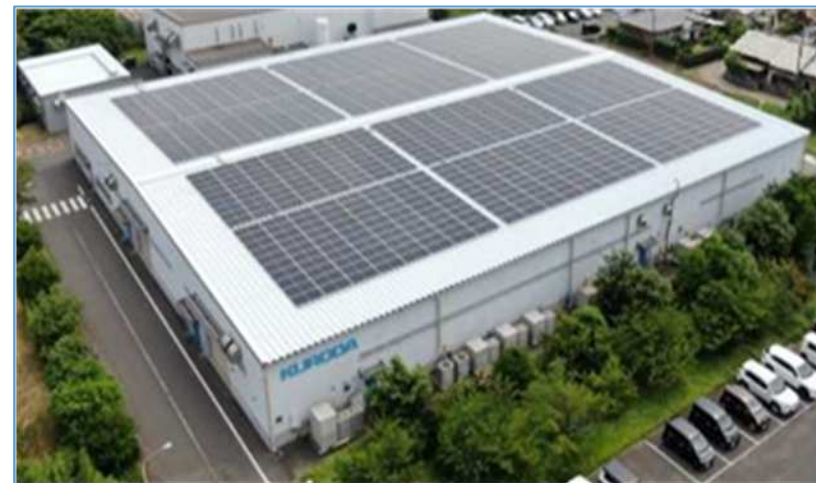
新たに太陽光パネルを設置した富津工場 (写真はツーリング生産棟)
