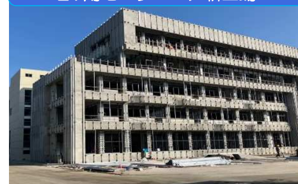
無錫隆盛新能源科技で建設中のEV用モーターコア新工場
