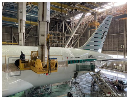
リブレット施工作業風景
