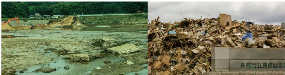
■岡山県倉敷市真備町
