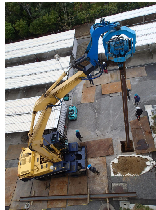
写真左：クレーンによる施工の様子
