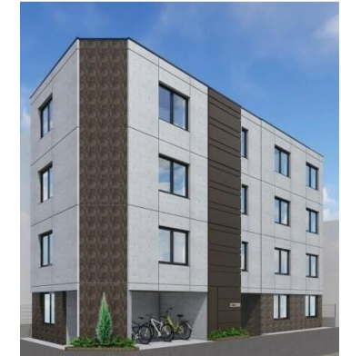
RAMii板橋大和町
