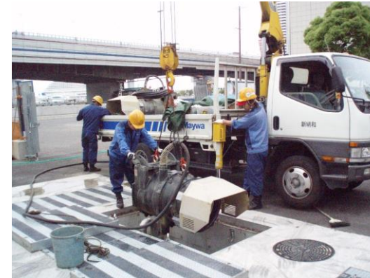
K市殿 雨水排水ポンプ (横軸軸流)
