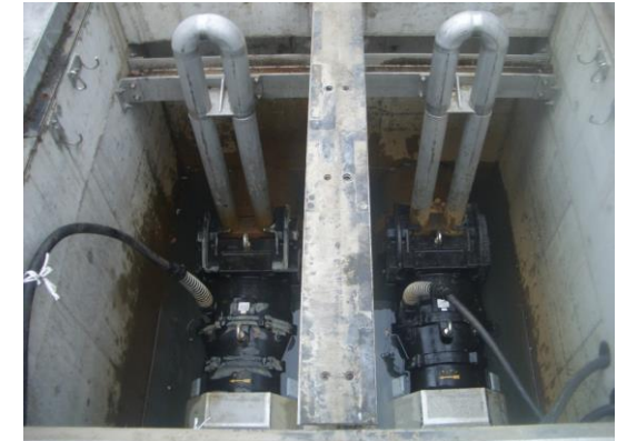
K市殿 雨水排水ポンプ (横軸軸流)
