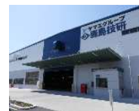
鹿島技研新本社工場
