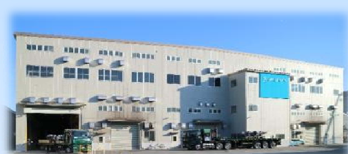
新台車枠工場
