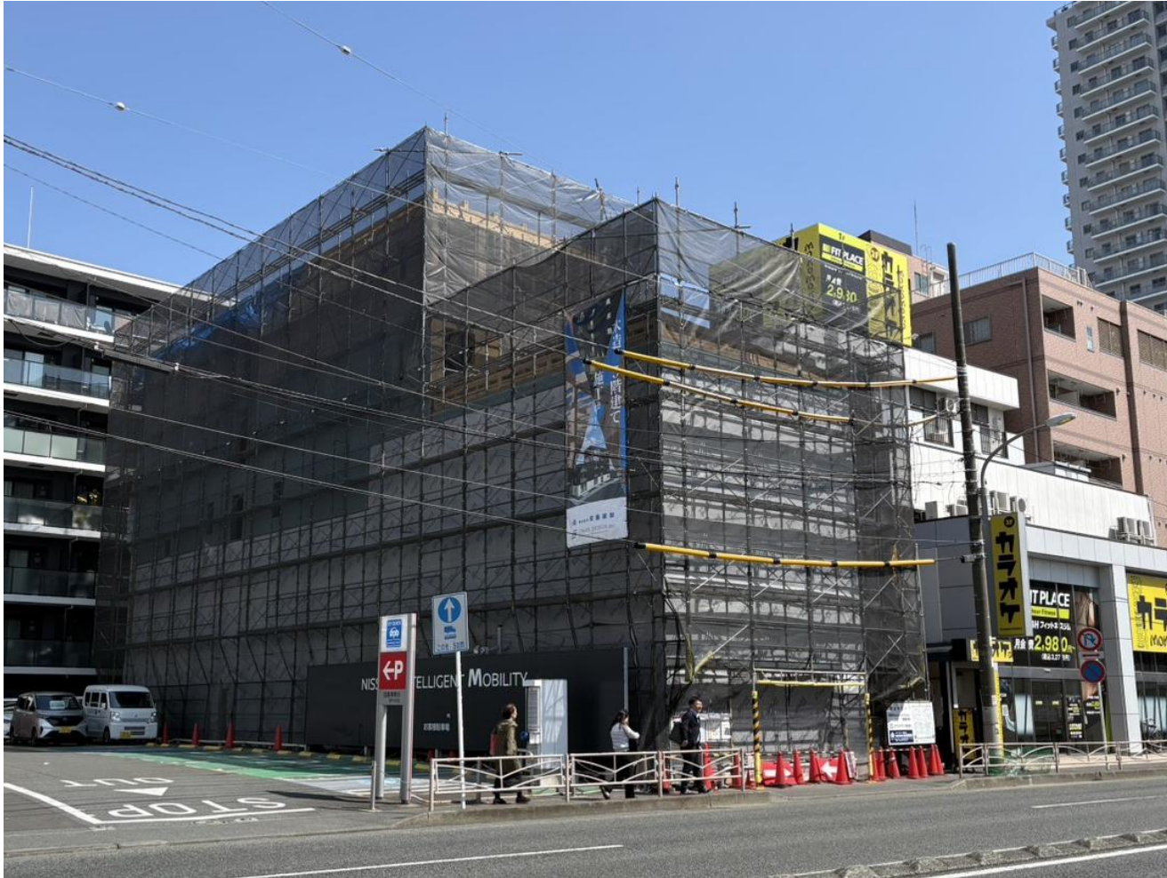
横浜市 木造5階建て現場写真
