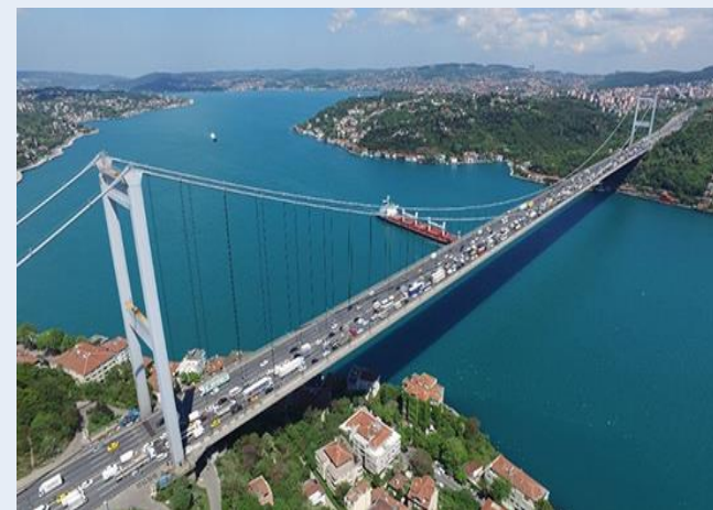
トルコ共和国「第2ボスポラス橋ハンガー交換工事」を受注
