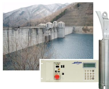
水位計システム
