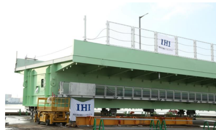
<関西国際空港連絡橋下り線の橋桁>
