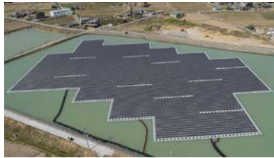
水上メガソーラー発電所
