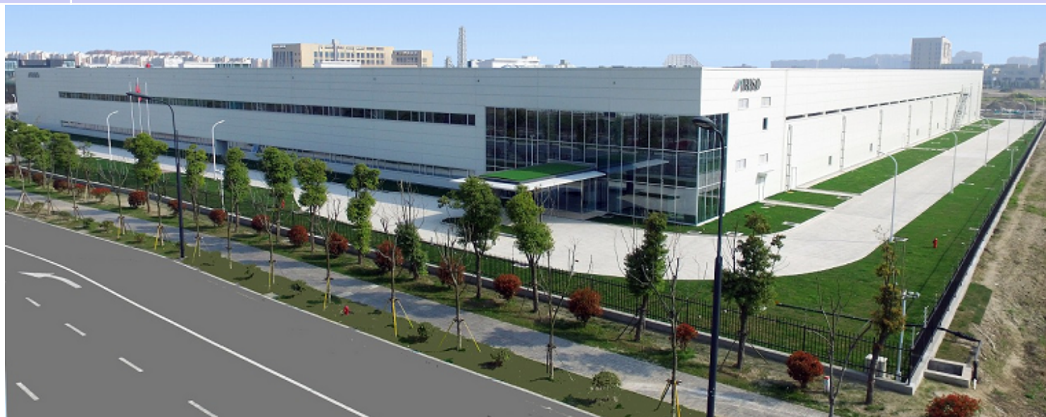
竣工した 南通工場
