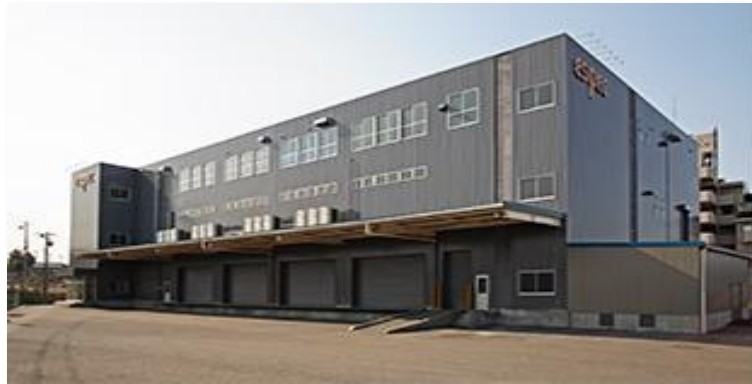
豊田試験所(愛知県豊田市)
