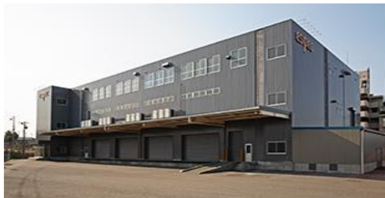
豊田試験所(愛知県豊田市)
