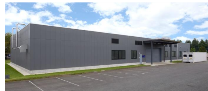
バッテリー安全認証センター (栃木県宇都宮市)
