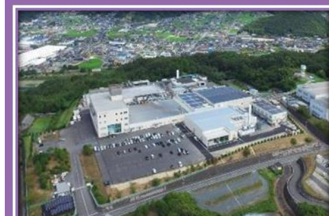
第1工場（旧第一工場）
