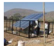
ソーラーパネルの設営
