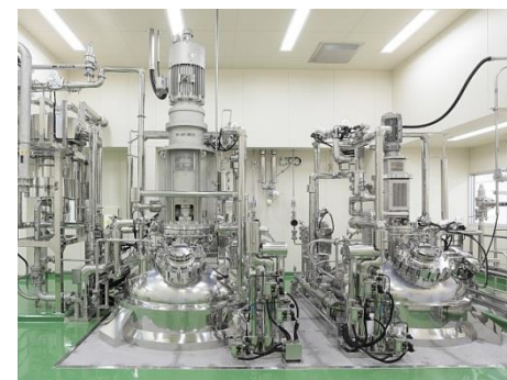
バイオ 培養量産設備
