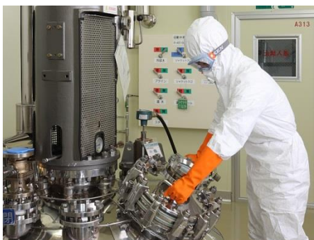
医薬 原薬量産設備
