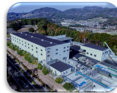
2026年6月 稼働予定 水処理施設 (都田テクノプラント)
