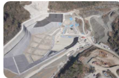
2022年2月 稼働 新規管理型最終処分場
