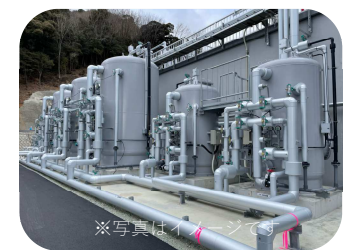
2026年4月以降 稼働予定 新規水処理施設
