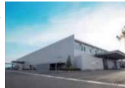
真空バルブ・遮断器工場
