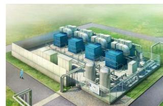
下水消化ガス発電システム
