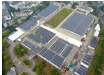
太陽光発電システム (中国東莞市における工場)
