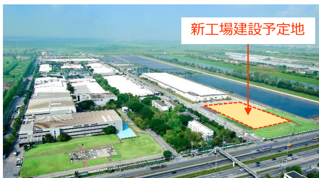
タイ バンパイン工場
