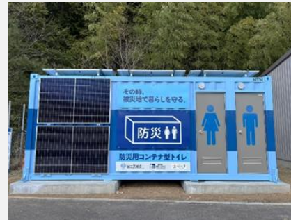
防災道の駅「丹波のまほろば」に設置
