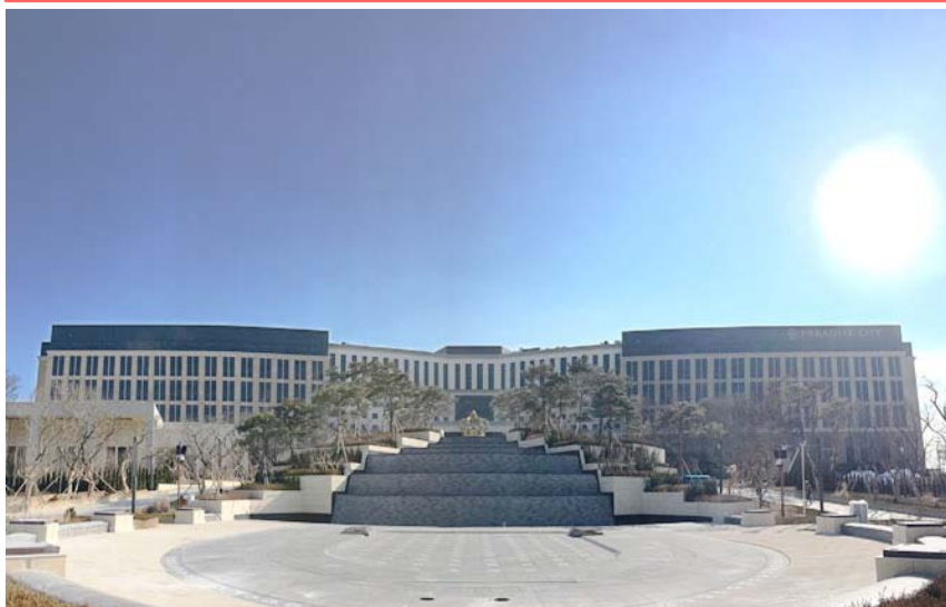
<工事進捗 (2017年1月12日時点)>
