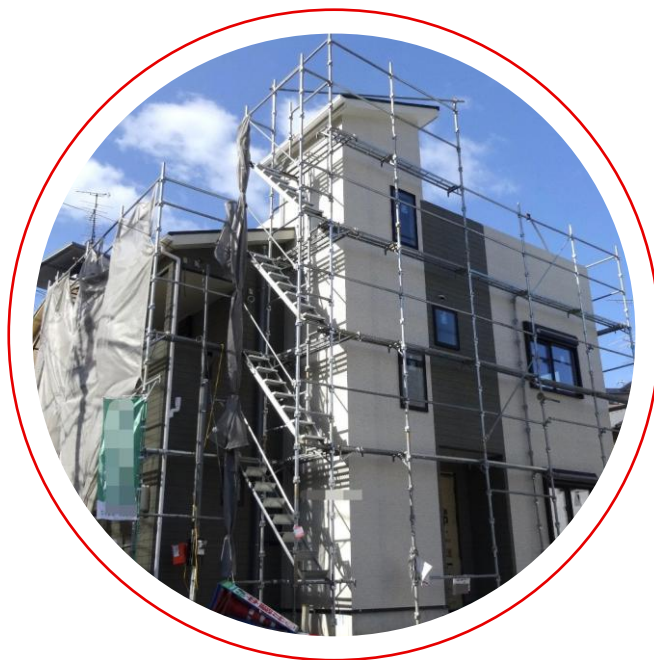
くさび式足場
