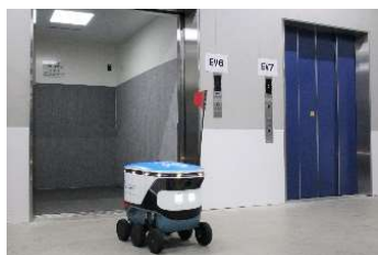
エレベータとロボットが連携する様子
