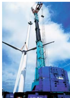
陸上で風車のブレード据付を行うオールテレーンクレーン
