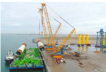
港湾で風車の部材積込を行うクローラクレーン
